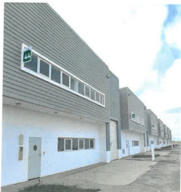
Figure 2 : Bâtiments industriels du Parc
