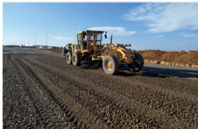
**ILLUSTRATION 4 : TRAVAUX DE MISE EN ŒUVRE DE LA COUCHE DE FONDATION EN GNF À L'AIDE DE LA NIVELEUSE**
