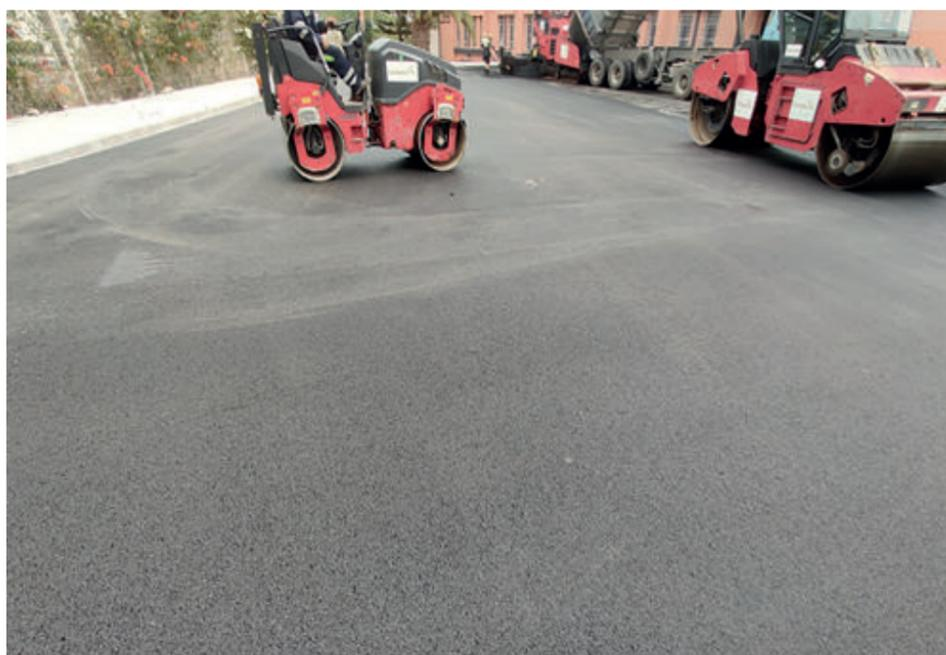
**ILLUSTRATION 5 : COMPACTAGE DE LA COUCHE DE ROULEMENT EN ENROBÉ BITUMINEUX**
